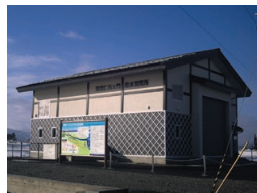
仁右工門用水発電所（富山県）
