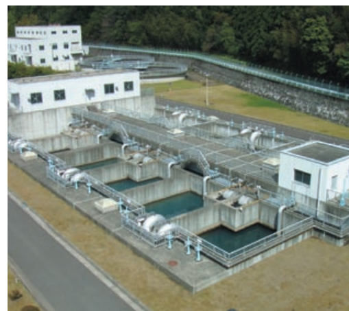
大井川広域水道企業団（静岡県）
