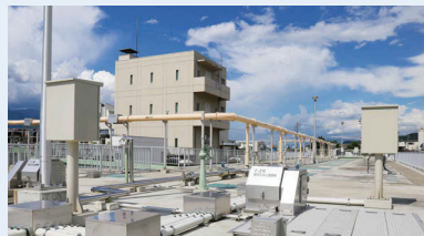
松尾浄化センター（長野県飯田市）
