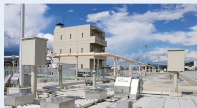
松尾浄化センター（長野県飯田市）
