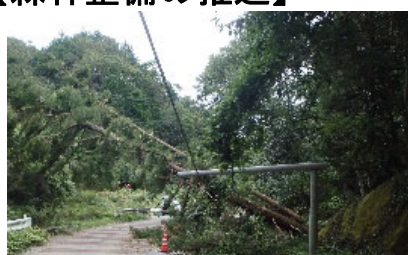
倒木により電線断線
