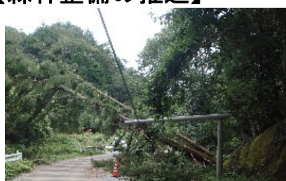
倒木により電線断線
