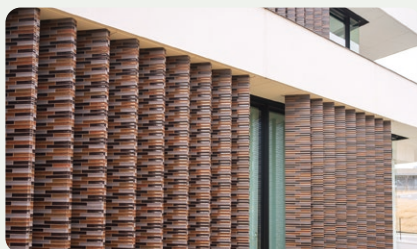
常滑の焼き物を用いたルーバー
