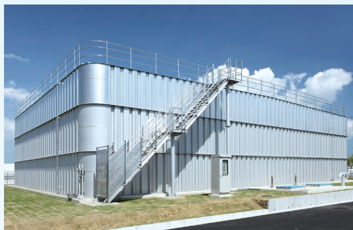
金田配水場(千葉県木更津市)
