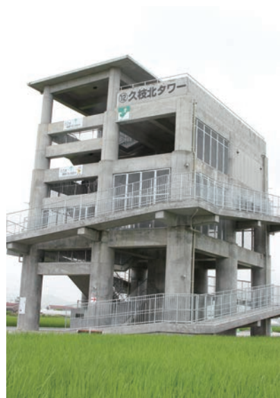
旧緊急防災・減災事業：津波避難タワー（高知県南国市）
