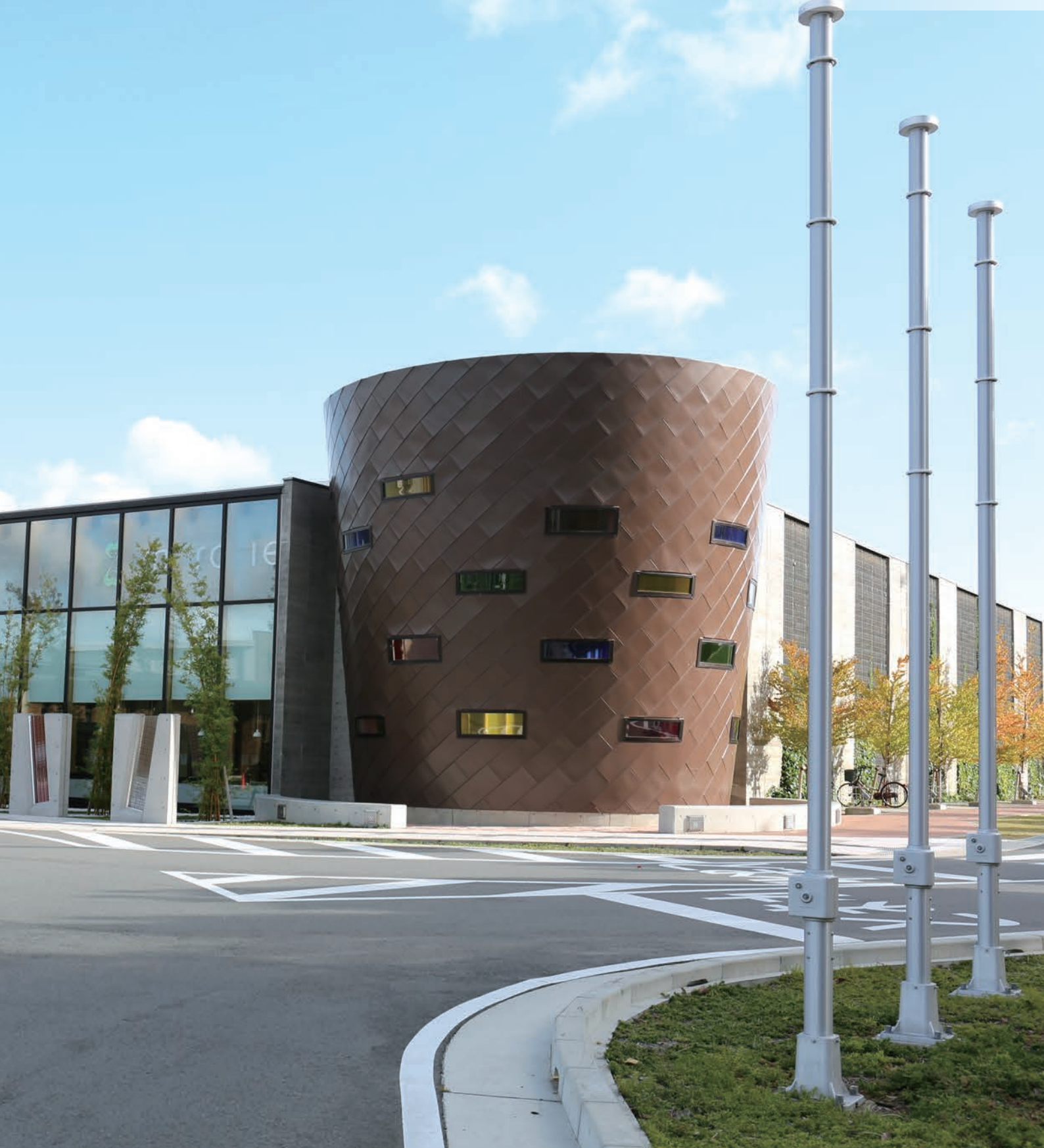
西脇市茜が丘複合施設 Miraie(みらいえ)／兵庫県西脇市
