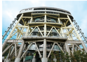
佐賀地区津波避難タワー (高知県黒潮町)
