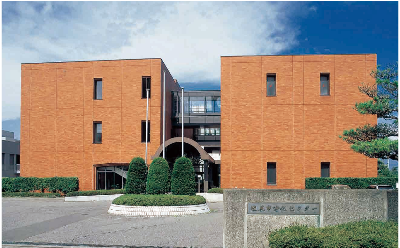
下水道事業：塩尻市浄化センター（長野県塩尻市）
