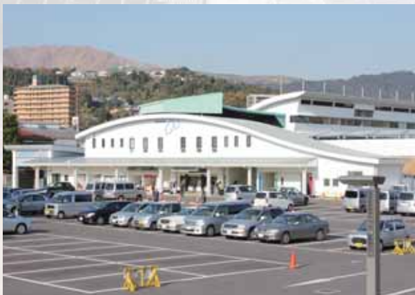
正門には場外発売窓口を設置
