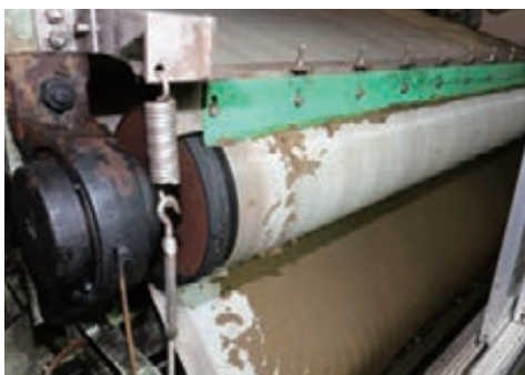
▲汚泥脱水機内部
