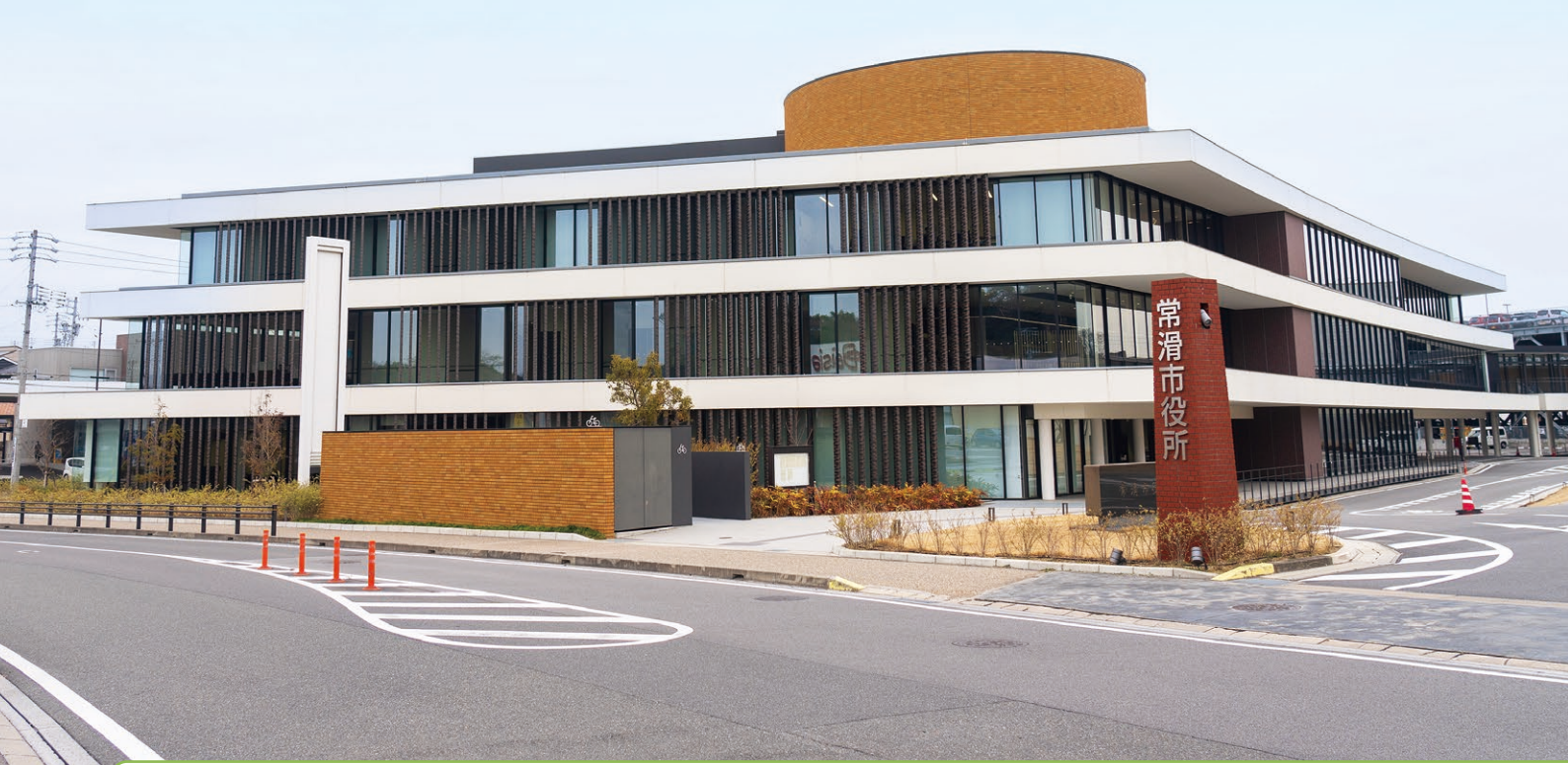
常滑市役所 概要 所在地:愛知県常滑市飛香台3丁目3番地の5 / 供用開始:令和4年1月 / 延べ床面積:9,792㎡ / 構造:鉄骨造 基礎免震構造
