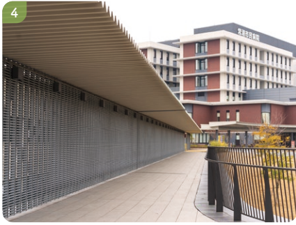
連絡通路* 市役所と市民病院、立体駐車場をつなぐ連絡通路です。雨の日も傘を差さずに3つの建物を行き来することができます。
