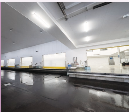
荷受室 *衛生面と荷降ろしの効率性を考慮し、80cmの段差を設けています。
