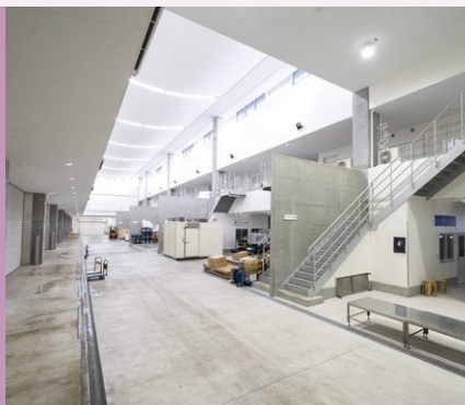
仲卸売場 *卸売業者から仕入れた商品を小売業者などに小分けして販売する、仲卸業者の売場です。2階には事務所を設けています。
