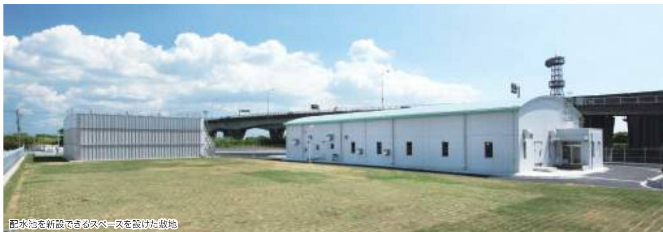
薬品注入設備
