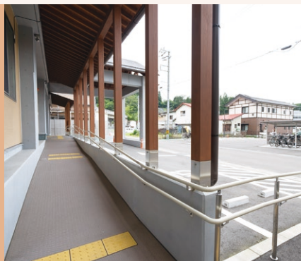
スロープ * 庁舎入口にスロープを設置し、車椅子の方でもご来場いただきやすい施設になっています。
