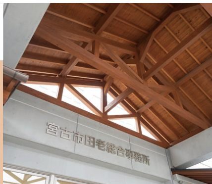
庁舎入口の庇 * 多く人の目に触られる庁舎入口の庇には、温かみのある木材を使用しています。
