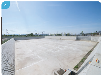
4 調整池広場 * 雨水を貯留するためのスペースですが、イベント会場などにも利用しています。
