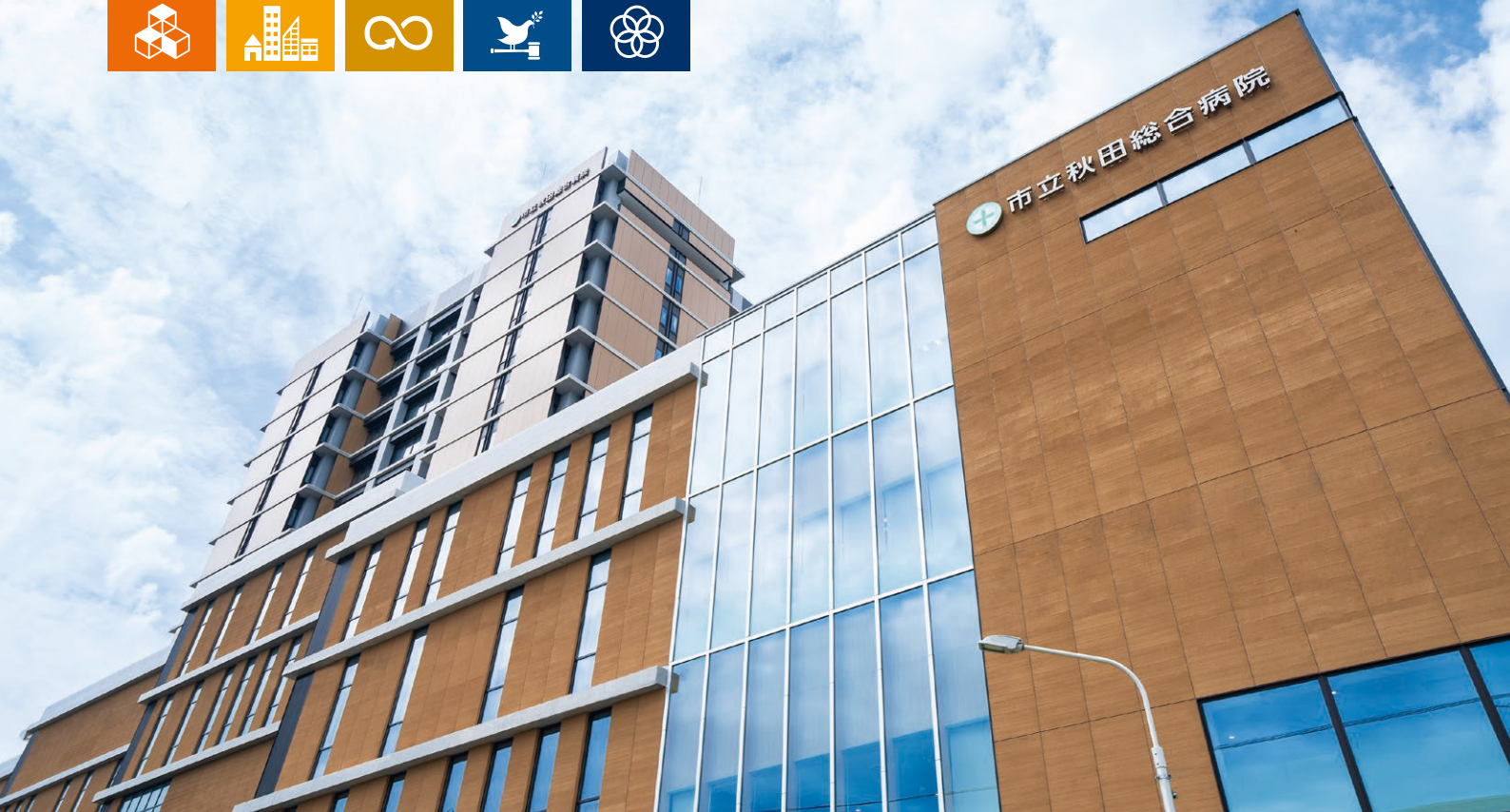
市立秋田総合病院 概要 所在地:秋田県秋田市川元松丘町4-30 / 竣工:令和4年9月 / 延床面積:約31,321.2㎡ / 構造:鉄骨鉄筋コンクリート造 13階建
