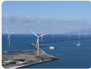
秋田港洋上風力発電所
