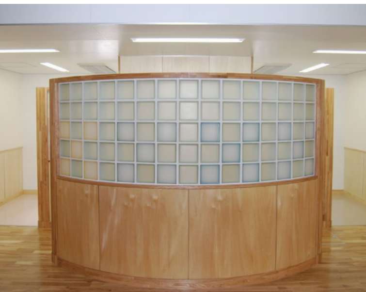
▲トイレ目隠し(ブロック側面には修斉草薙児童の手書きメッセージが)
