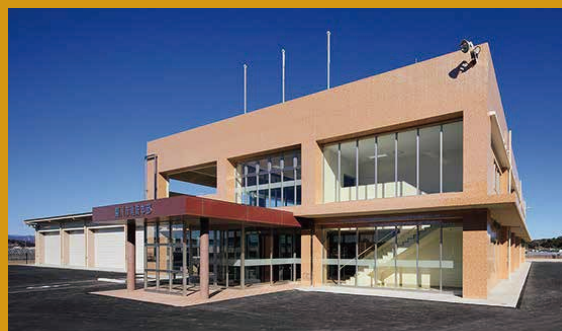
静岡県菊川市消防庁舎
