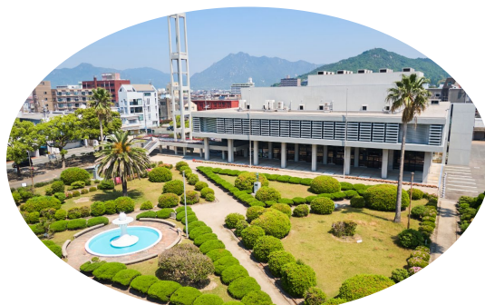
防府市公会堂（山口県防府市）
