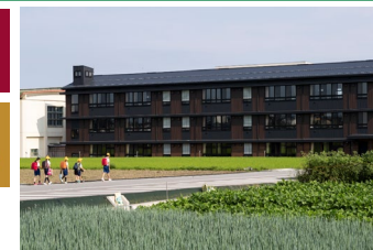
富山県魚津市 星の杜小学校
