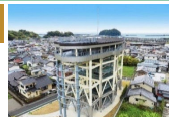
高知県黒潮町 佐賀地区津波避難タワー
