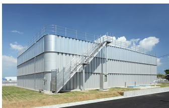
千葉県木更津市 金田配水場
