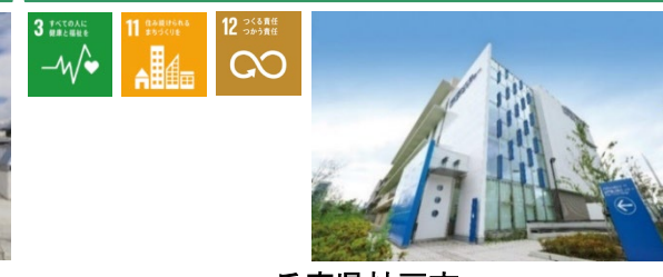
兵庫県神戸市 兵庫県立粒子線医療センター付属神戸陽子線センター
