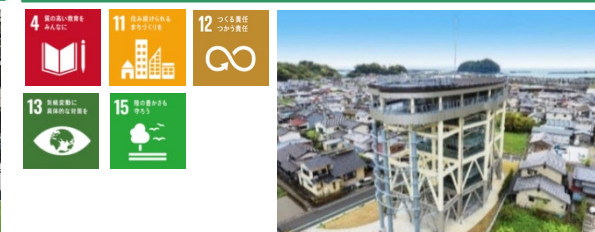
高知県黒潮町 佐賀地区津波避難タワー
