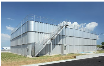
千葉県木更津市 金田配水場
