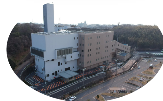
寝屋川市クリーンセンター （大阪府寝屋川市）
