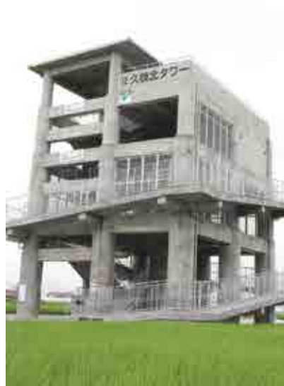
旧緊急防災・減災事業：津波避難タワー（高知県南国市）
