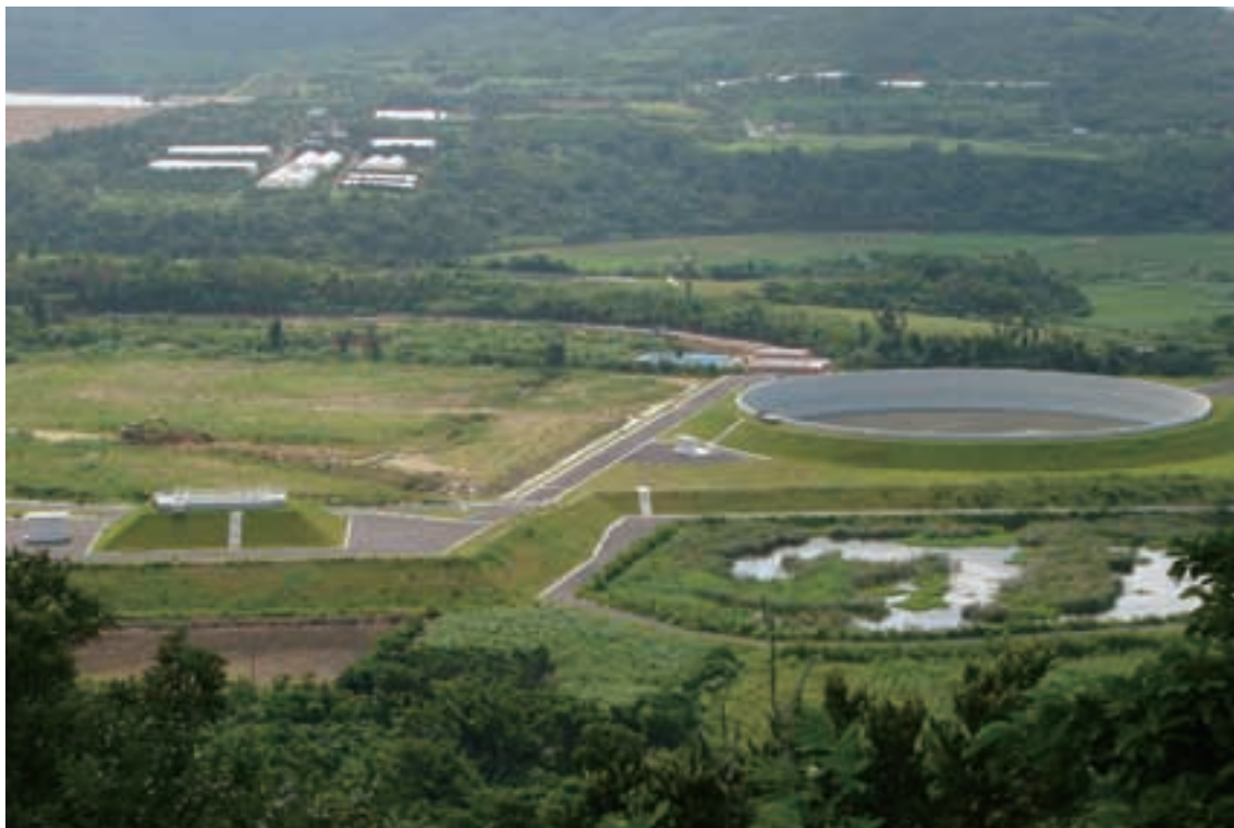
水道事業：白水原水調整池（沖縄県石垣市）
