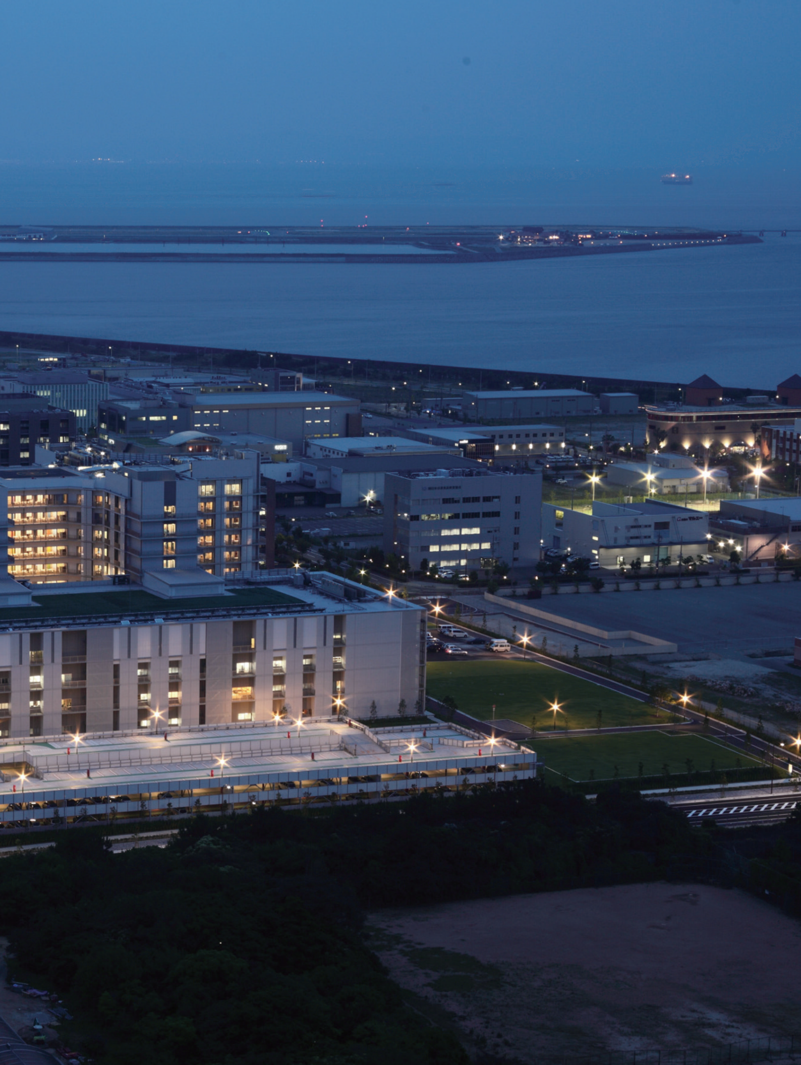
病院事業 / 神戸市立医療センター 中央市民病院 / 兵庫県神戸市
