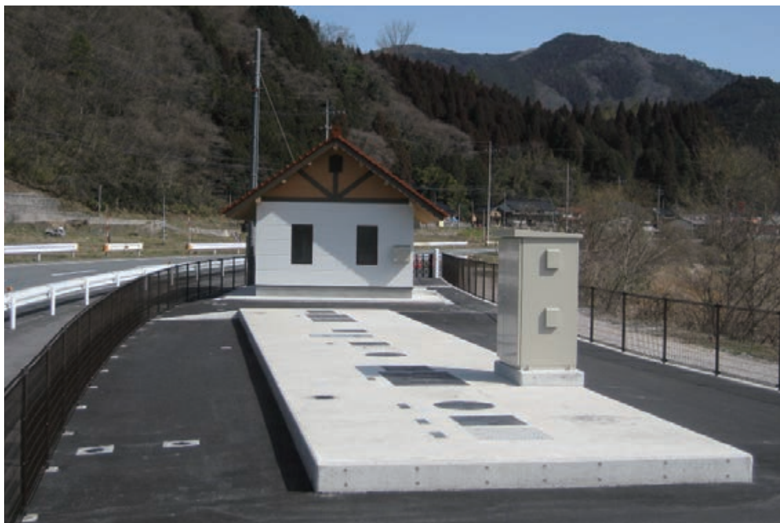
千屋浄化センター（岡山県新見市）
