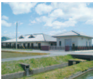
清水地区農業集落排水処理施設(岐阜県揖斐川町)
