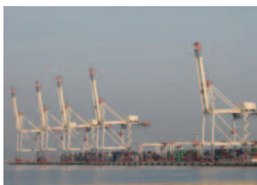
アイランドシティコンテナターミナル ガントリークレーン(福岡市)
