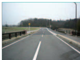
町道内池水口線(滋賀県日野町)
