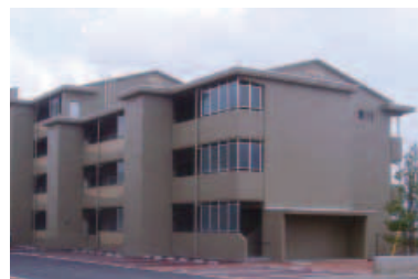
市営住宅賀露団地(鳥取市)
