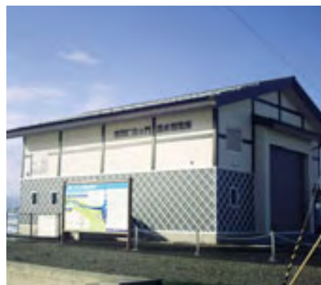
仁右エ門用水発電所（富山県）
