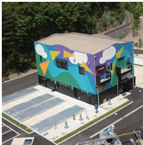
白川浄水場（佐賀県有田町）
