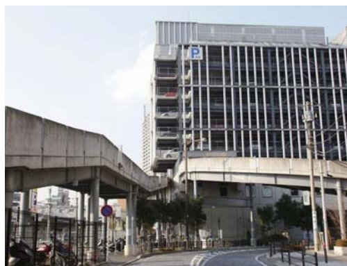
橋本駅北口第2自動車駐車場（相模原市）
