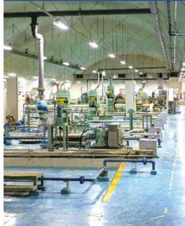
トンネル式処理場 (水処理設備)
