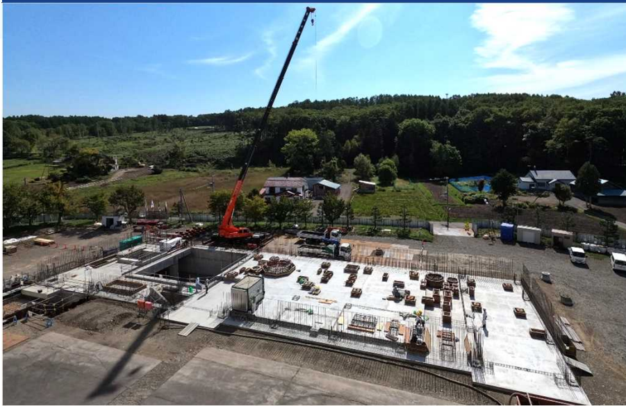
建設中の1号汚泥焼却施設
