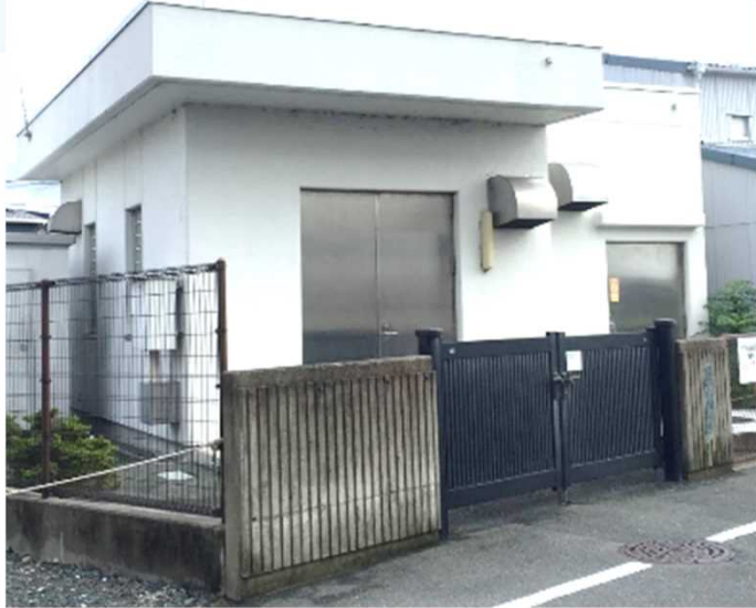
村櫛中継ポンプ場
