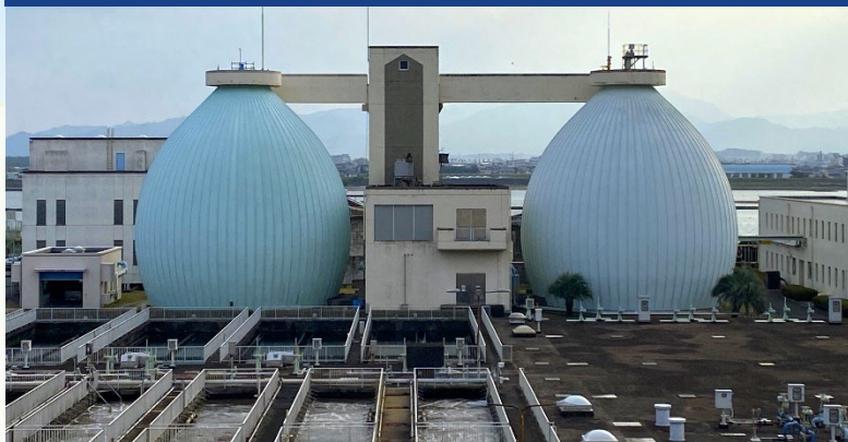
宮崎処理場 No.2卵形消化槽
