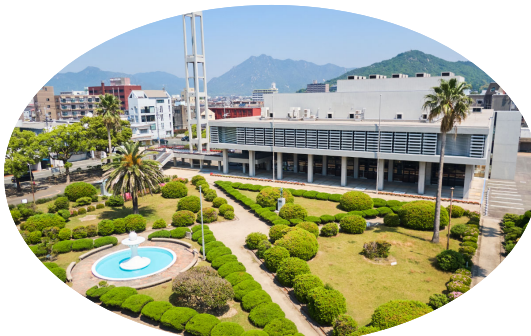
防府市公会堂（山口県防府市）
