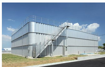
千葉県木更津市 金田配水場
