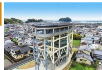
高知県黒潮町 佐賀地区津波避難タワー
