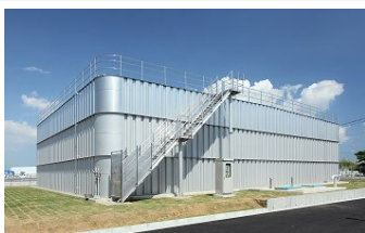
千葉県木更津市 金田配水場
