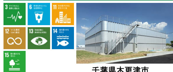
千葉県木更津市 金田配水場
