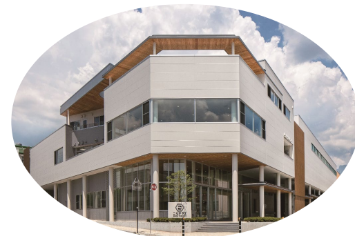
こもテラス（長野県小諸市）
