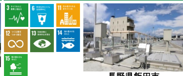
長野県飯田市 松尾浄化管理センター
