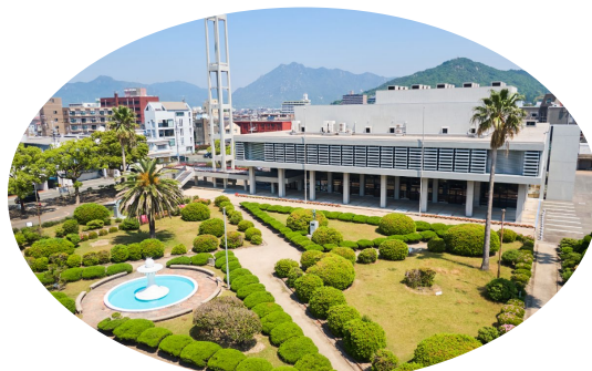
防府市公会堂（山口県防府市）
