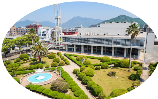
防府市公会堂（山口県防府市）
