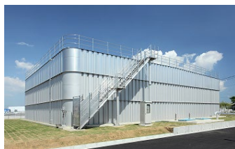
千葉県木更津市 金田配水場
