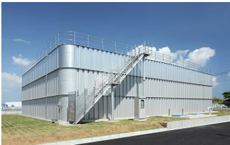
千葉県木更津市 金田配水場
