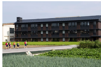
富山県魚津市 星の杜小学校
