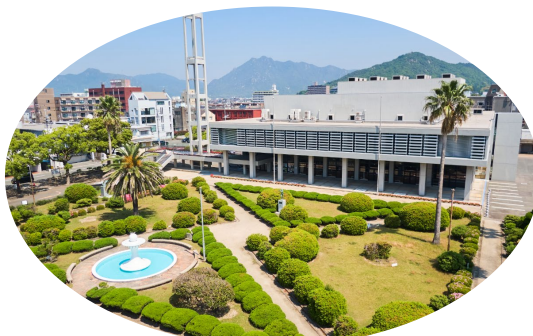
防府市公会堂（山口県防府市）
