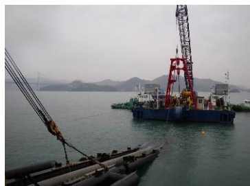
【海底管の布設工事】
