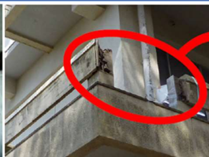
老朽化により手すりが落下
