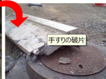
老朽化により手すりが落下
