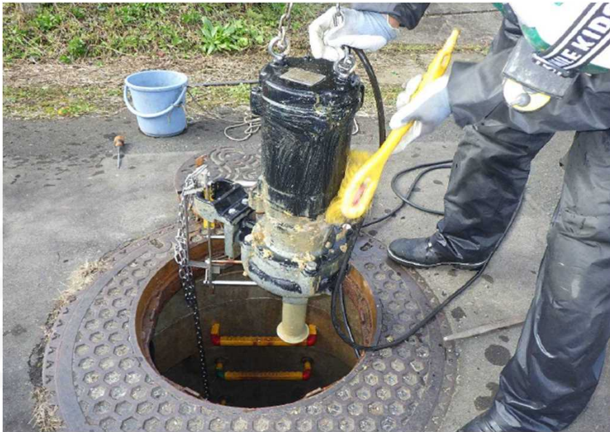
マンホールポンプの清掃
