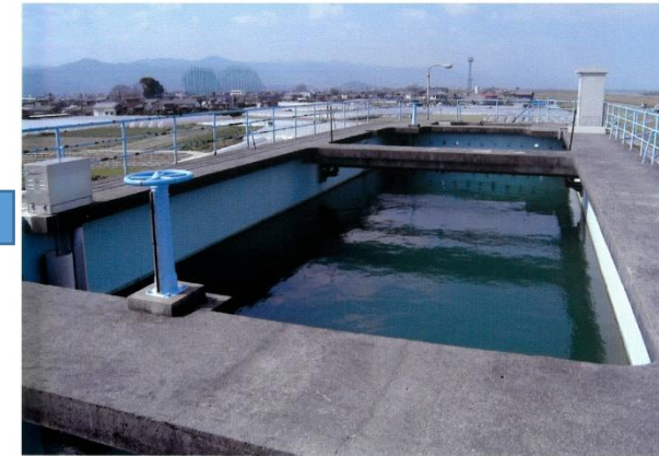
浄水場の浄水処理量により 水面が変化
