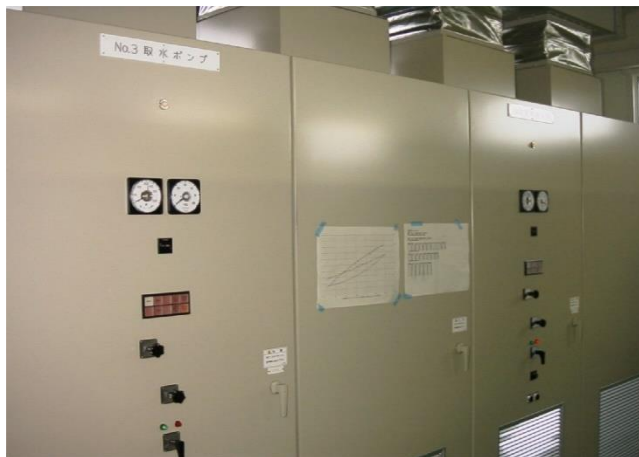
沈砂池の水位が一定となるよう インバータによる回転数制御
