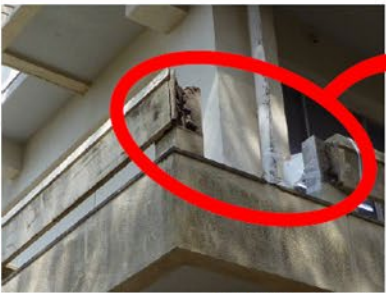
老朽化により手すりが落下
