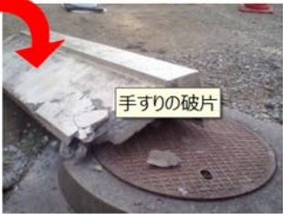
老朽化により手すりが落下
