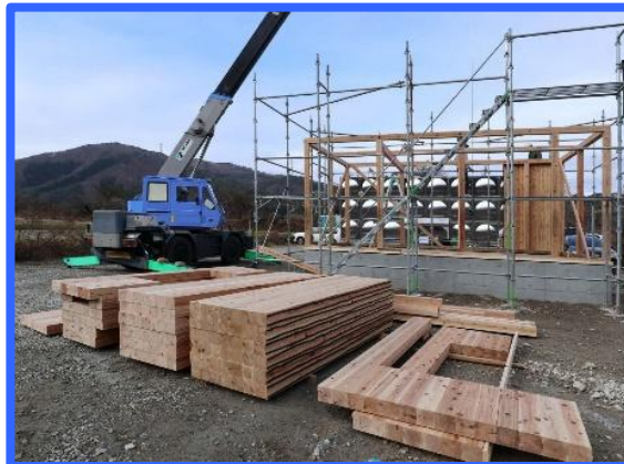
②外壁・屋根建て込み
