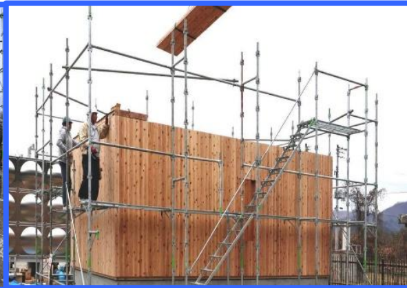
②外壁・屋根建て込み
