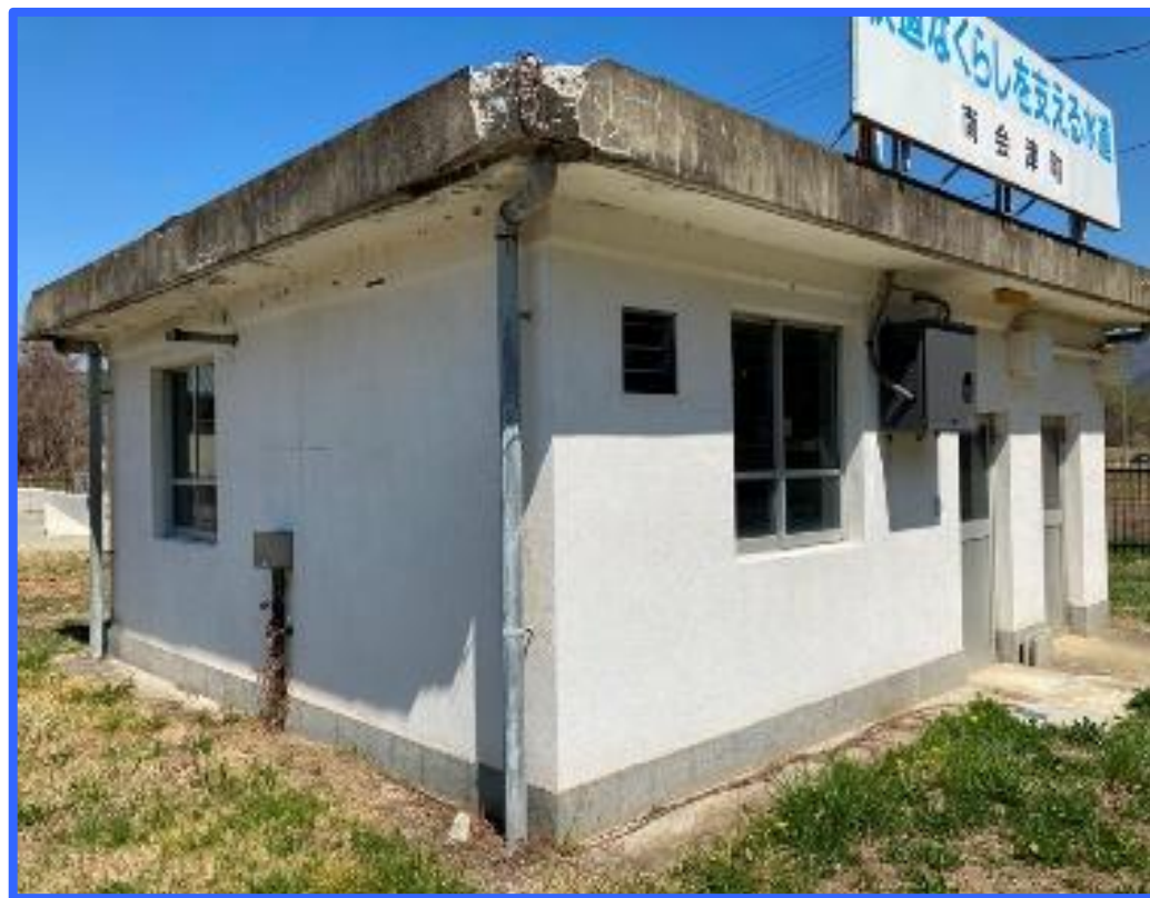
コンクリートブロック造の建屋
