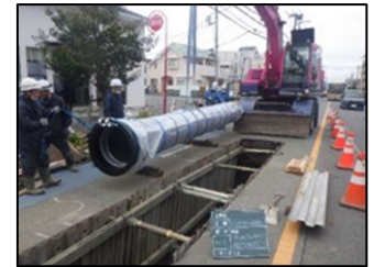
（耐震管の敷設工事）
