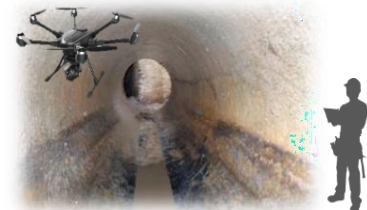
(管路等劣化状況点検用ドローン)
