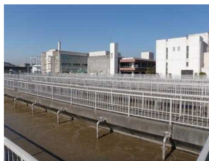
下松市浄化センター（終末処理場）エアレーションタンク～最終沈澱池
