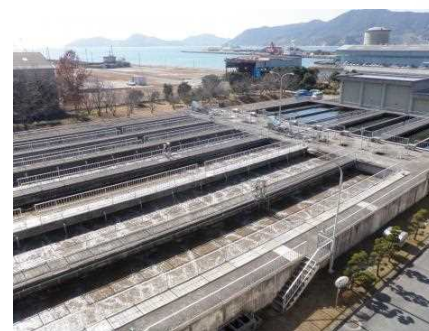
下松市浄化センター（終末処理場）エアレーションタンク～最終沈澱池
