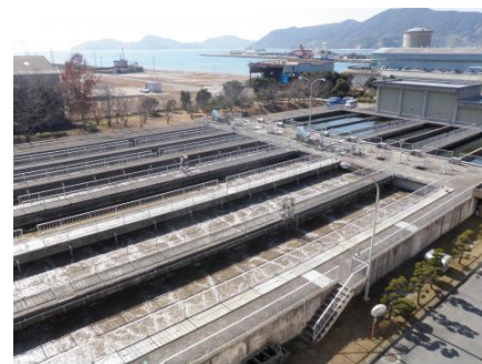
下松市浄化センター（終末処理場）エアレーションタンク～最終沈澱池
