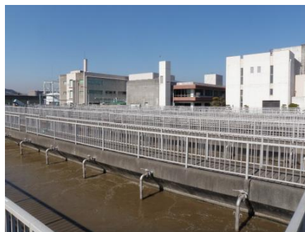
下松市浄化センター（終末処理場）エアレーションタンク～最終沈澱池
