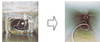
プラスチック材により既存管きょの内面を被覆
